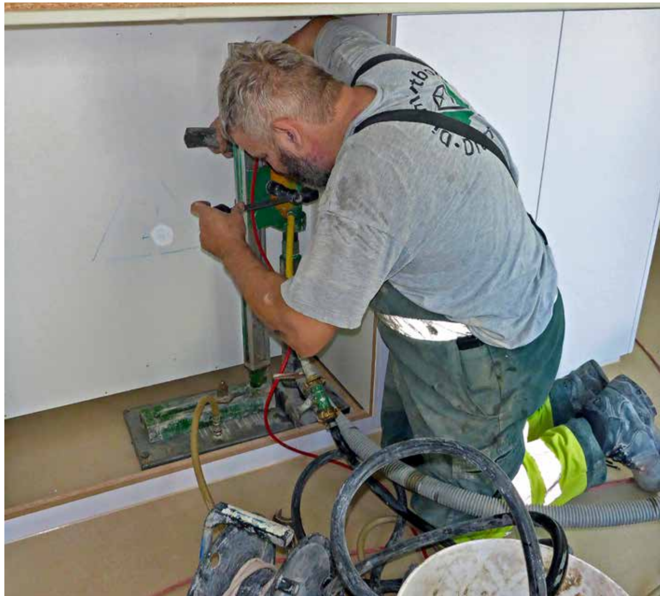
Kernbohrung zur Entnahme von Proben vor Ort.
