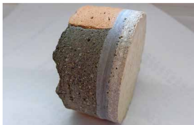
Eine Kernbohrprobe aus einem Epoxyharzboden.
